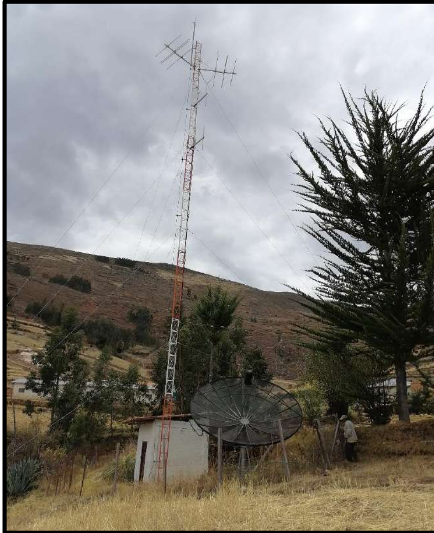
“MANTENIMIENTO CORRECTIVO ESTACION CPACC PACOBAMBA, DISTRITO DE HUANCASPATA, PROVINCIA DE PATAZ”
