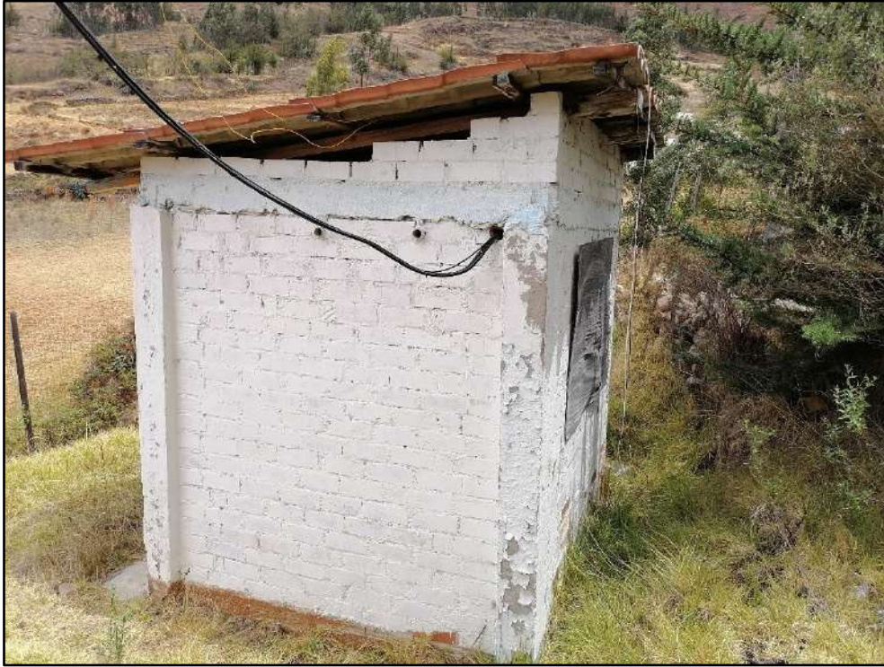
Imagen 5. Zona exterior de la caseta presenta deterioro y zonas despintadas, por lo que se requiere refacción.
