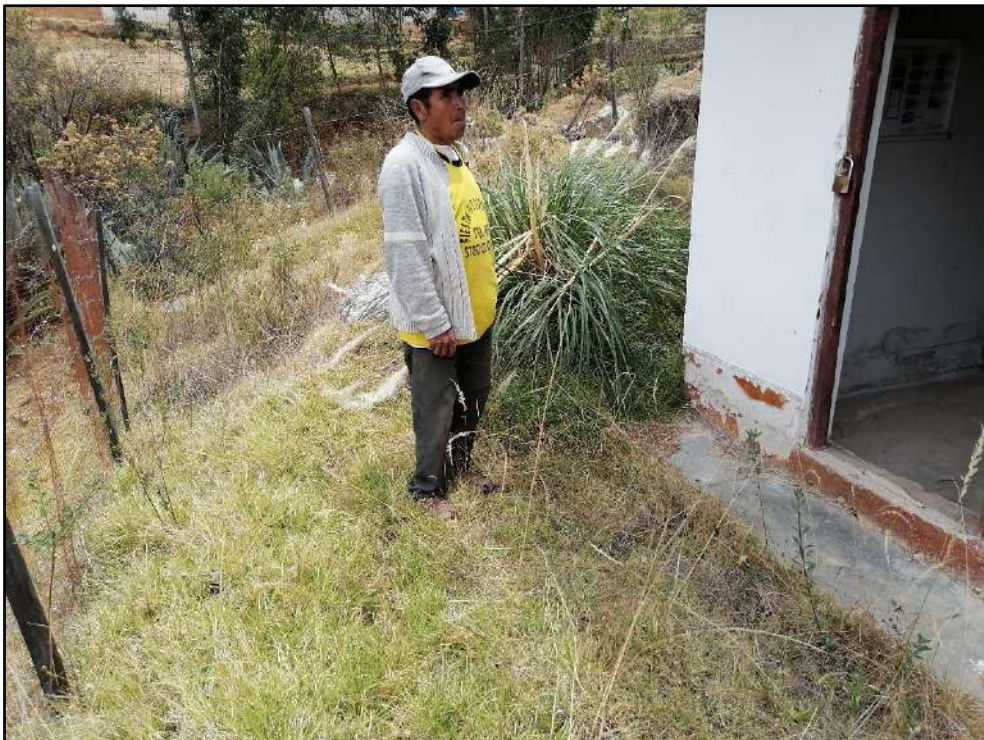
Imagen 8. Presencia de maleza alrededor de la caseta de comunicación de la estación CPACC Pacobamba.
