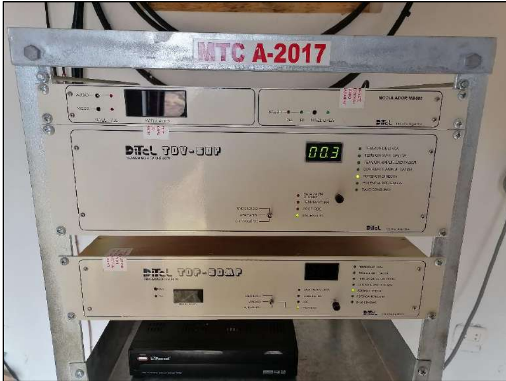
Imagen 13. Potencia directa que marca el transmisor de TV.
