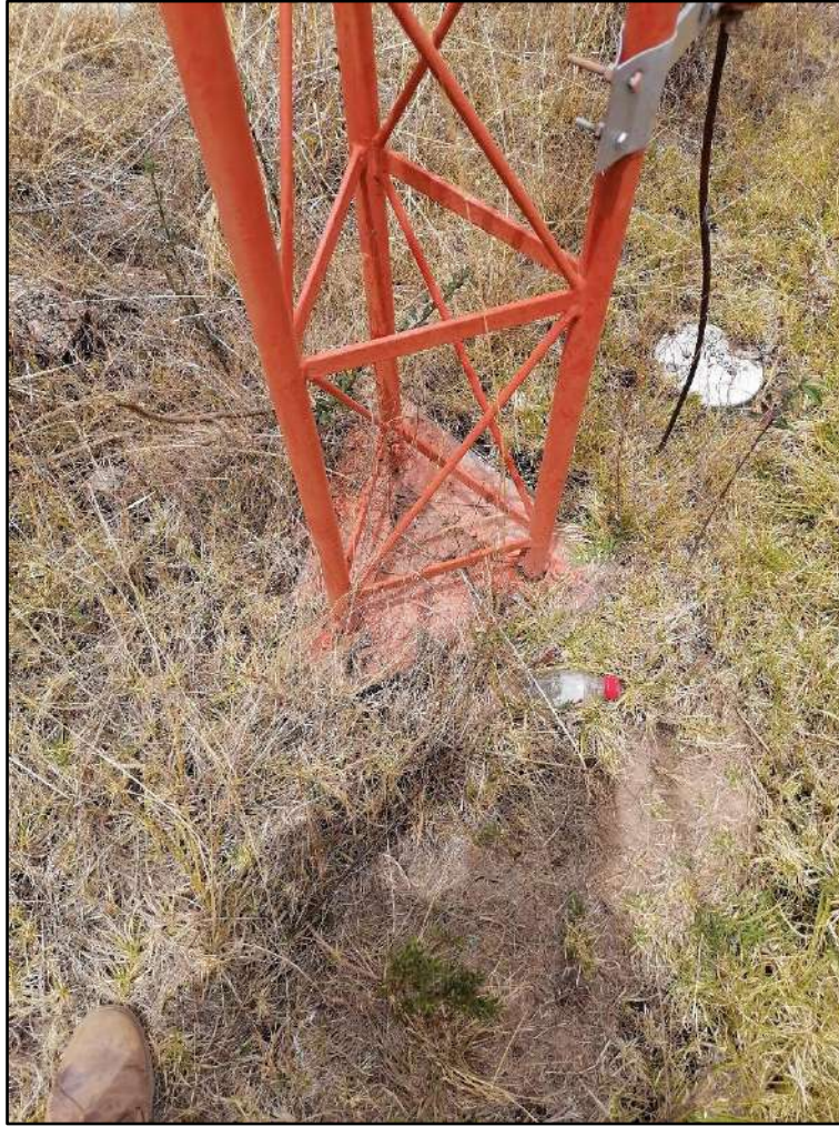
Imagen 7. Cuerpos de torre de transmisión presentan zonas despintadas, por lo que requiere pintado en colores blanco y rojo según normativa.
