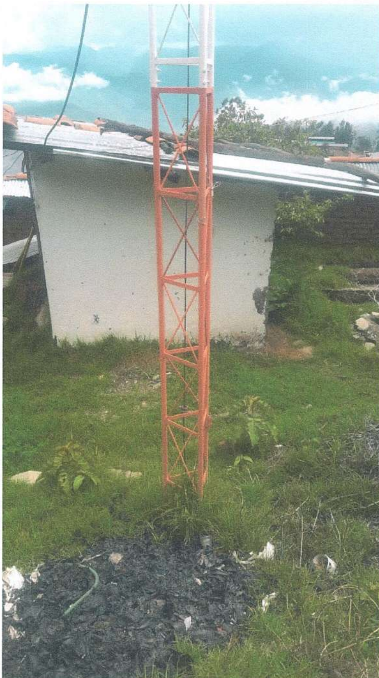
Ilustración 5. Torre de radiacion.
